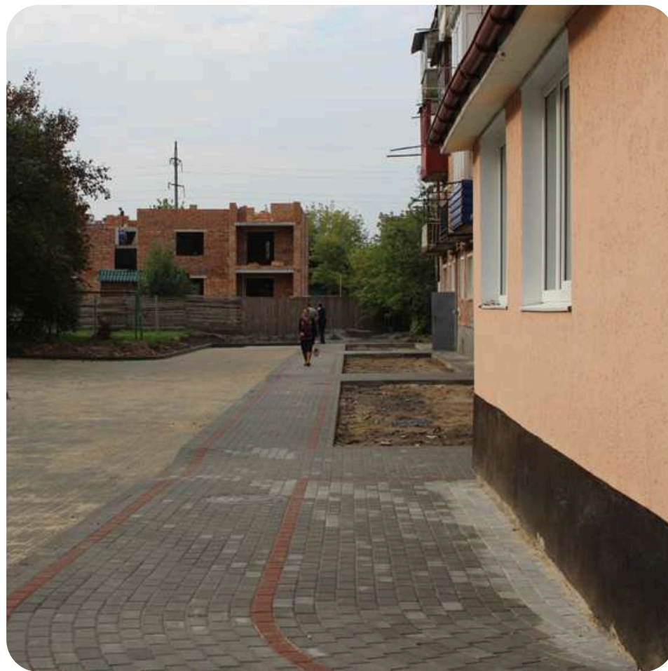
вул. Ізяславська-Садова - 3413,7 м2, 2 551 156,74 грн
