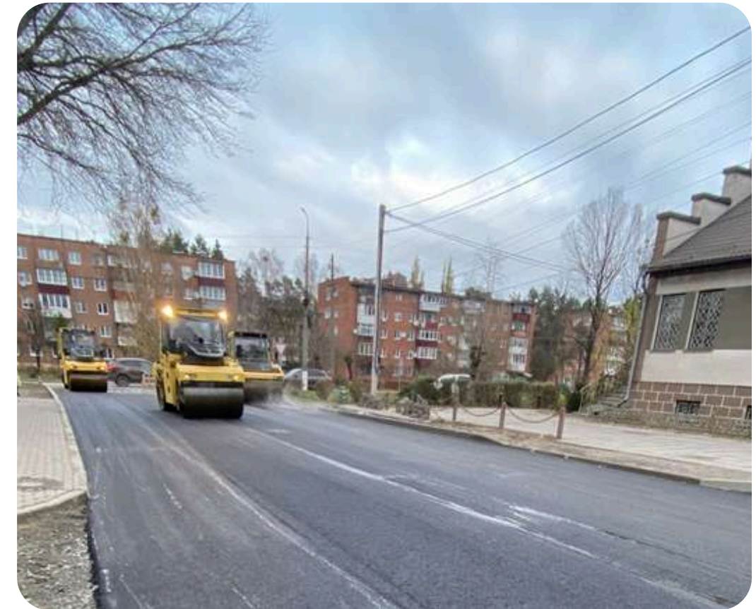
вул. Звитяги (роботи тривають) - 3121,890 м2, 5 880 421,85 грн
