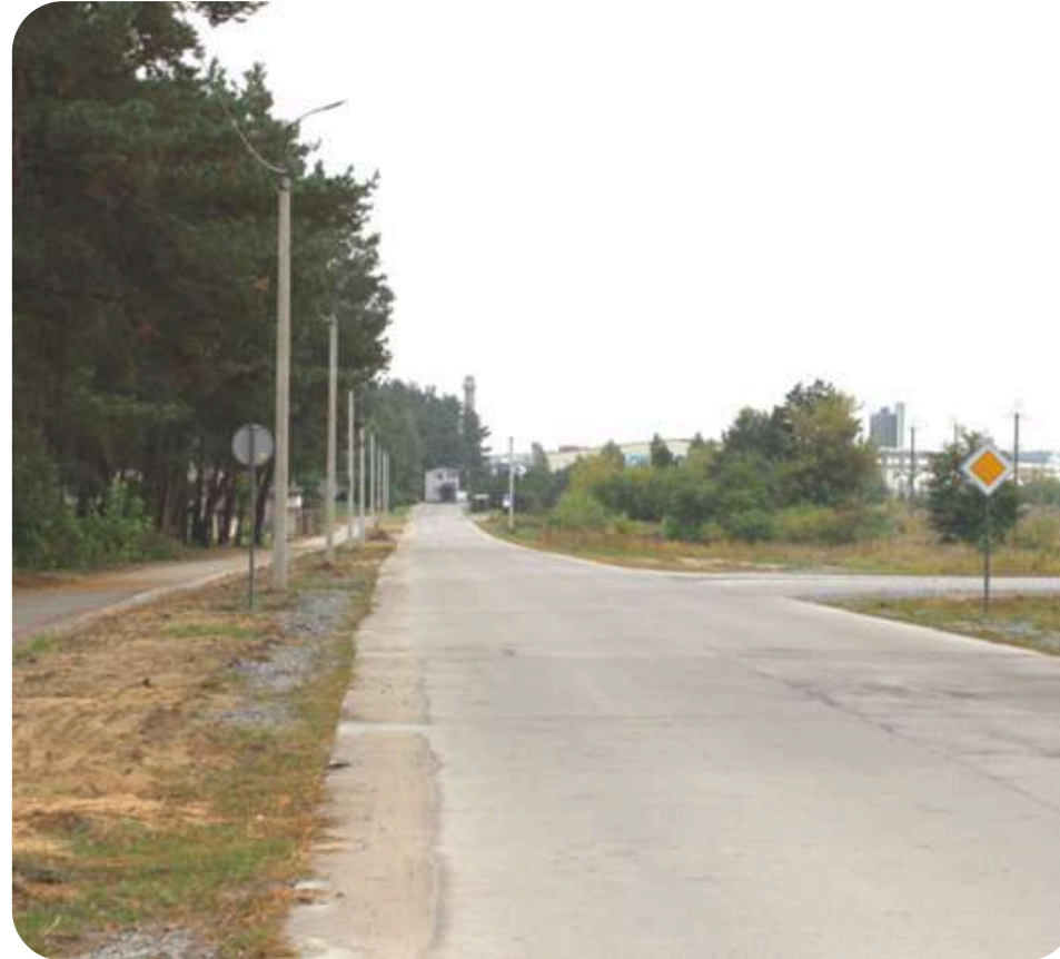
вул. П. Сагайдачного - 5283,36 м2, 3 911 373,14 грн
